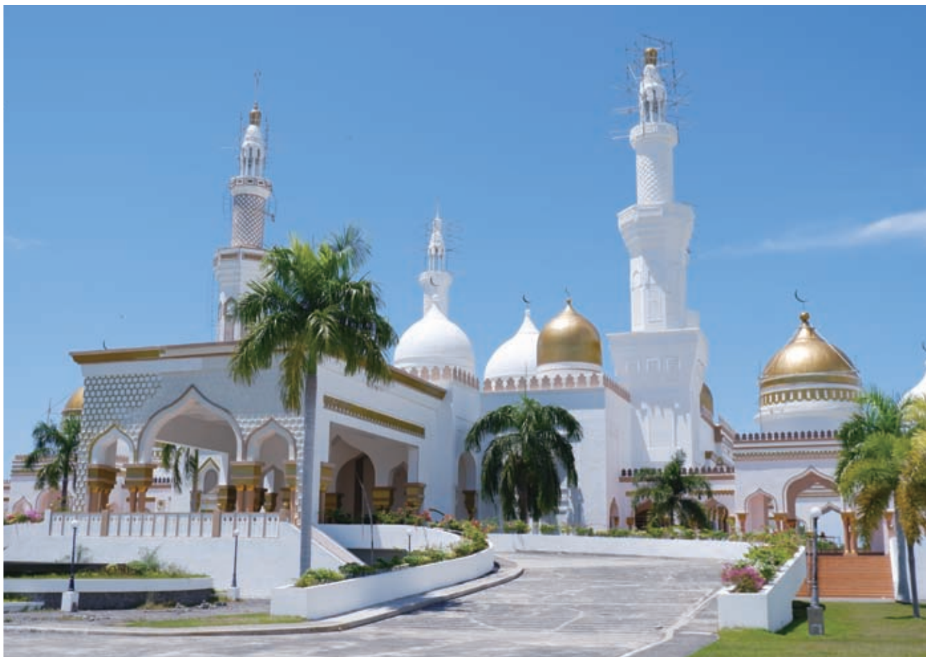
コタバトのランドマーク、グランドモスク。ブルネイ王国からの部分的資金援助を受け、2011年に建設された＝写真は全て本誌編集部撮影
