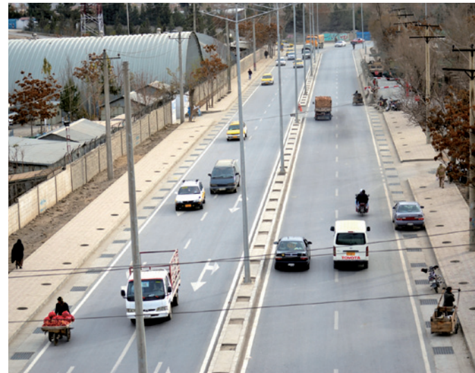
アフガニスタン・カブール市道路整備プロジェクトのパイロットプロジェクトとして施工した市内道路
