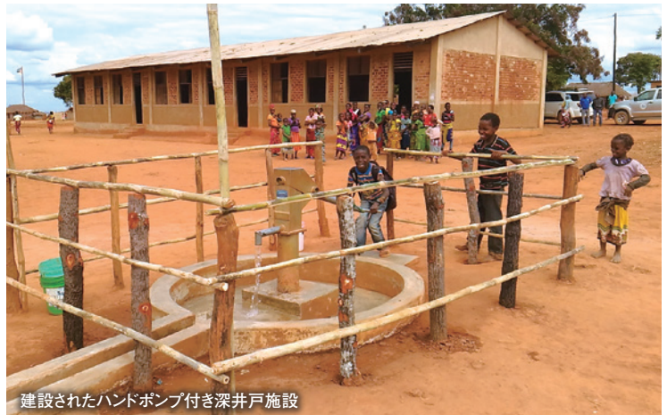
建設されたハンドポンプ付き深井戸施設
