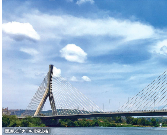
開通した「ナイル川源流橋」
