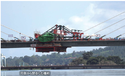
両側から閉合した橋桁
