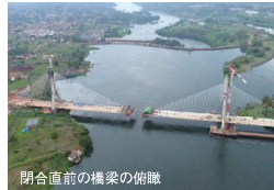
閉合直前の橋梁の俯瞰
