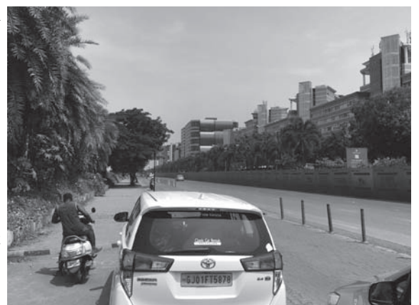
高速鉄道のムンバイ駅建設予定地付近。写真左側の地下に駅ができる(=川原氏提供)
